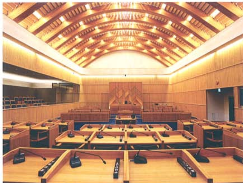
北海道の旭川市が森林環境譲与税を使って木材利用を推進している。家具産地のシンボルとして建設した新庁舎の議場は、梁にアーチ状のカラマツ集成材、内装材にトドマツを使用した重厚感のある大空間になっている。(関連記事p8参照)
