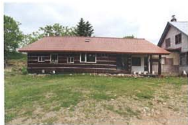
工房の外観。馬小屋だった建物を自分たちで改装したようだ。裏手には逸見さんが世話をする羊牧場がある
